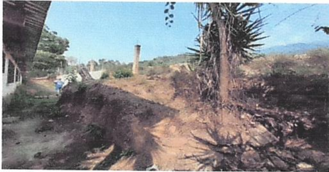
Foto 1: Construcción de muro de contención de Block.
